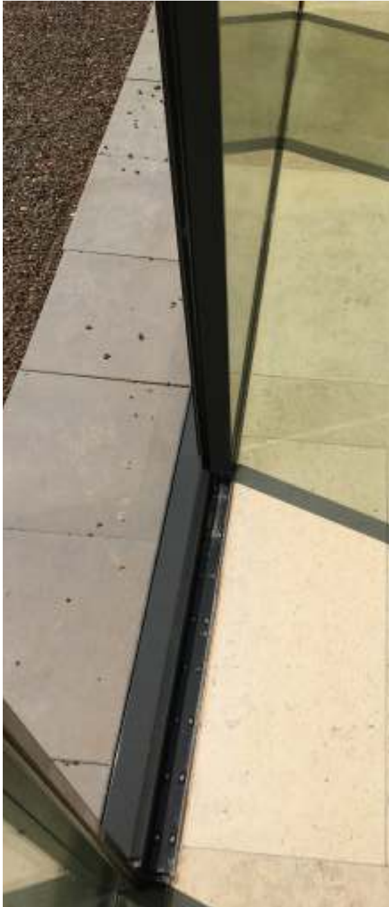
het "E"-profiel maakt het mogelijk overal schuifdeuren te maken
