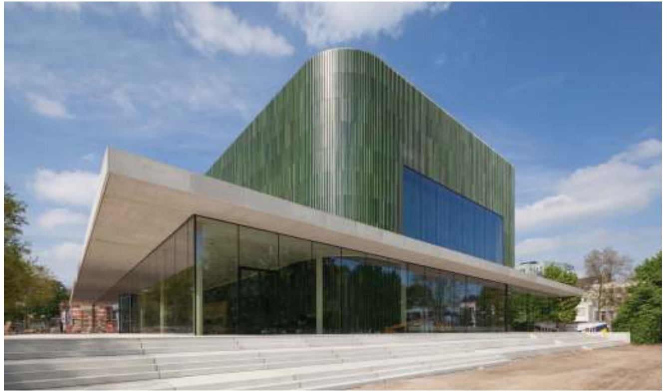
in de glazen plint zijn niet alleen de foyers van het publiek ondergebracht, maar ook die van de artiesten
