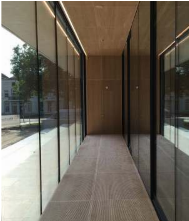
spouw met grote glazen deuren die samen voor geluidsreductie zorgen
