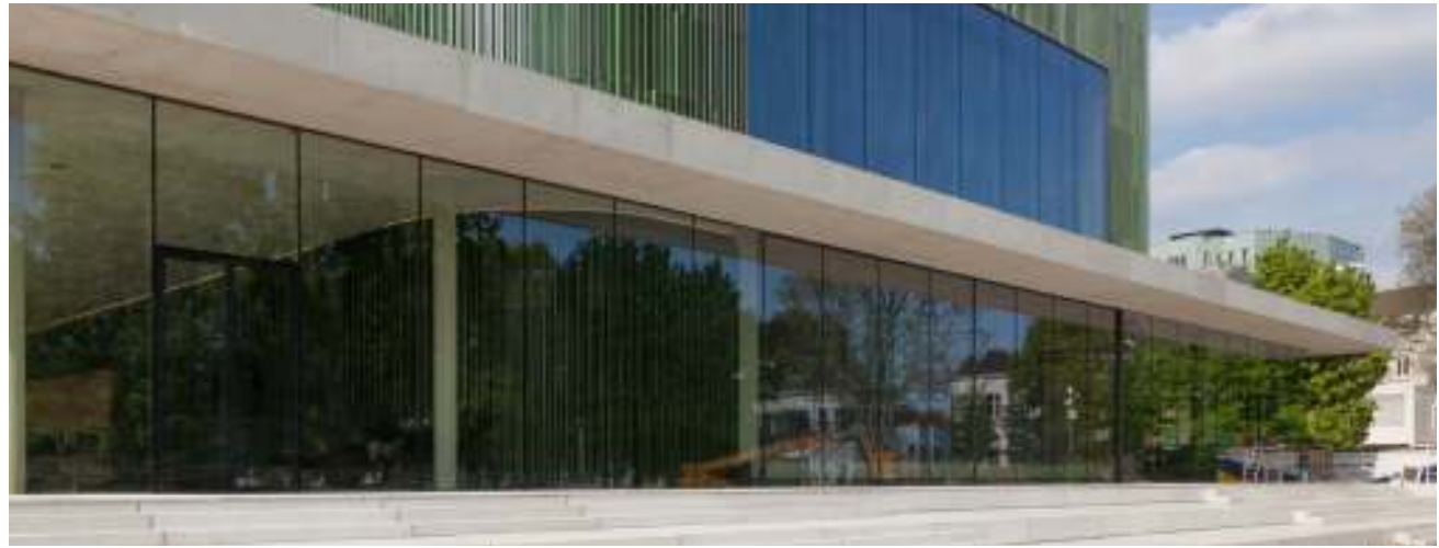
De enorme te openen glaspui bestaat uit twee deuren van 5 bij 8 meter die opgedeeld zijn in 8 glasplaten van 5 bij 2 meter
