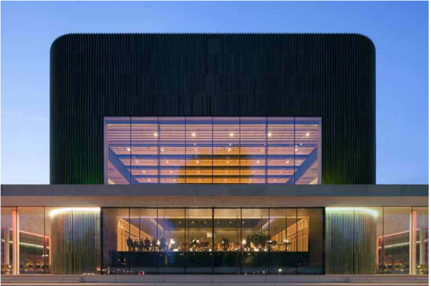
De glazen gevel onder de luifel kan volledig wegschuiven om de zaal te openen naar het park
