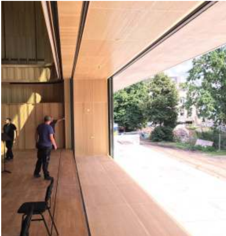
glazenpui van parkzaal in geopende toestand
