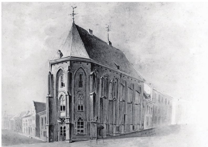
▲ Tekening van de Sint Nicolaaskerk uit 1858, dus kort voordat de kerk werd gesloopt.
