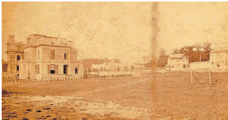
▲ Het bouwgebied naast de Utrechtseweg in 1886. In de verte vaag zichtbaar de dan net gereed gekomen Koepelgevangenis.
